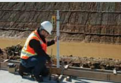
Avec la DR400 DigiRod™ de Spectra Precision®, le porte-mire qui contrôle la cote avec un laser rotatif peut désormais effectuer cette fonction sans mire. La combinaison tout en un d'un récepteur laser à affichage numérique, d'un distancemètre laser et d'un capteur d'inclinaison intégré fournit toutes les informations requises pour obtenir des lectures de cotes précises, sans mire, même avec une inclinaison atteignant 30°.
