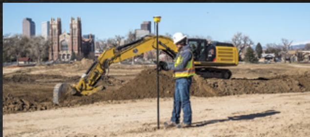
Le système de positionnement de chantier Trimble pour géomètres est composé de l'antenne intelligente GNSS SPS986 ou SPS785, du carnet de terrain TSC7 ou de la tablette T7 ainsi que du logiciel Siteworks. Cette combinaison permet aux géomètres de travailler facilement sur des projets 3D complexes, de collecter leurs données encore plus rapidement et de visualiser les modèles 3D complexes plus facilement – ce de jour comme de nuit.
